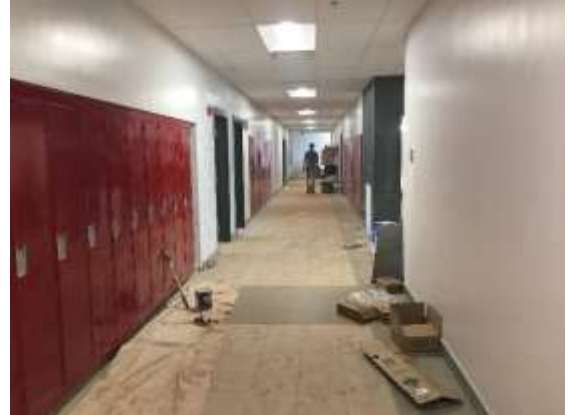
photo du corridor I
